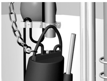
Рис. 18 Подъемная цепь, прикрепленная к насосу
